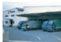
中央ロジスティックセンター
