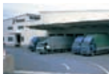
中央ロジスティックセンター
