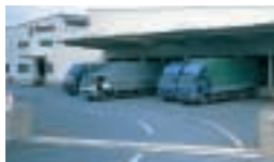
中央ロジスティックセンター
