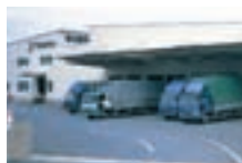
中央ロジスティックセンター
