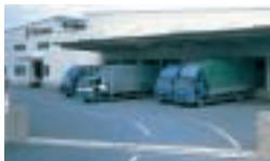
中央ロジスティックセンター
