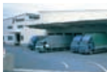
中央ロジスティックセンター
