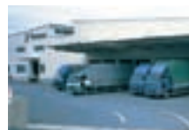
中央ロジスティックセンター
