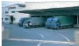
中央ロジスティックセンター
