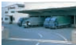
中央ロジスティックセンター
