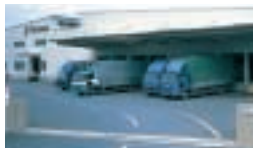
中央ロジスティックセンター
