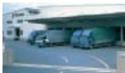
中央ロジスティックセンター
