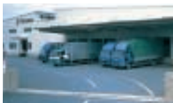
中央ロジスティックセンター
